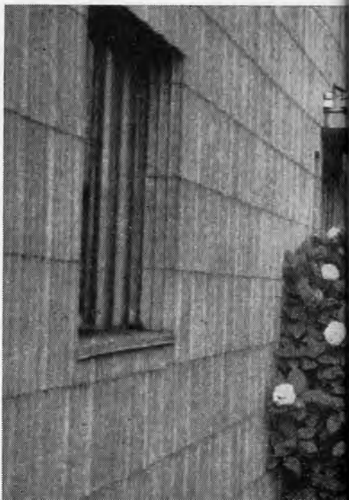
Le revêtement en tuiles de tôle galvanisée
